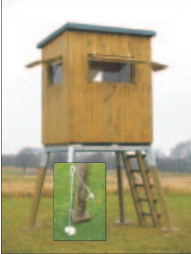
**Bockgerüst mit konischen Eckpfosten und Erdanker**
