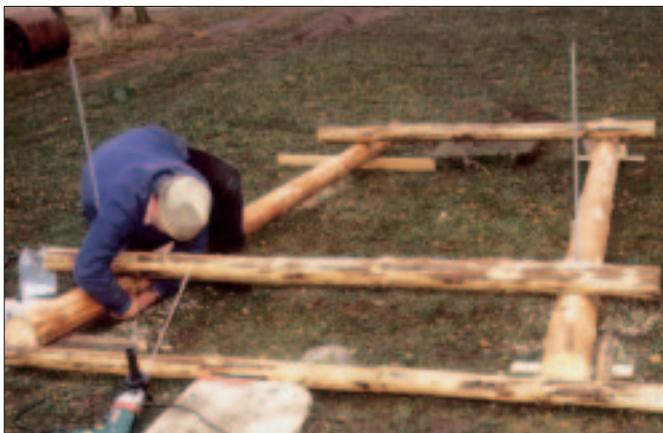
mit einem Schlangenbohrer durchgeführt. Die Verbindung der Hölzer erfolgt durch Verbolzen. Es werden Gewindestangen M 12 Güte 8.8, Bulldogdübel ( 50 mm und U - Scheiben 58/6 mm) verwendet. Die Gewindestangen werden durch die Bohrungen gesteckt und dann passend abgesägt. Die Bulldogdübel zwischen den Hölzern und die großen Unterlegscheiben unter den Muttern gewährleisten eine feste Verbindung.
