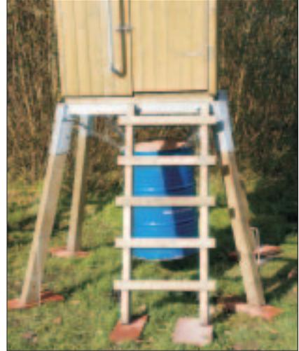
**Angehängter Ballast bei konischem Unterbau (Das Fass sollte aus rein optischen Gründen mit dunkler Farbe gestrichen werden.)**
